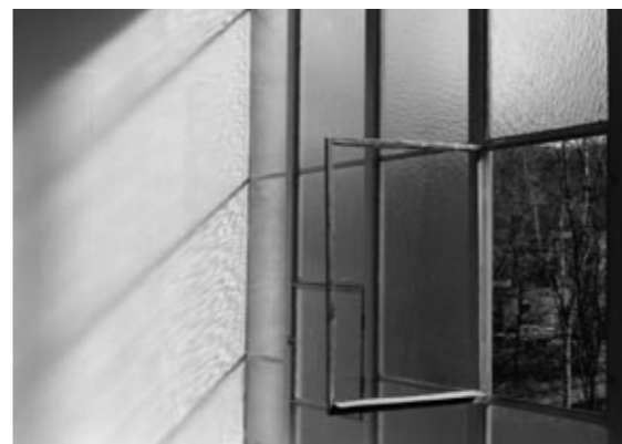
Změna formátů zasklení fasády přidáním vodorovných prvků v 50. letech (foto Transat architekti, 2001)
