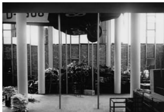
Zazděné přízemí Památníku - dočasná náhrada zasklení poškozeného spojeneckým bombardováním 20. 11. 1944 (foto F. Pešula 1945, MZA - Státní okresní archiv, Zlín)
